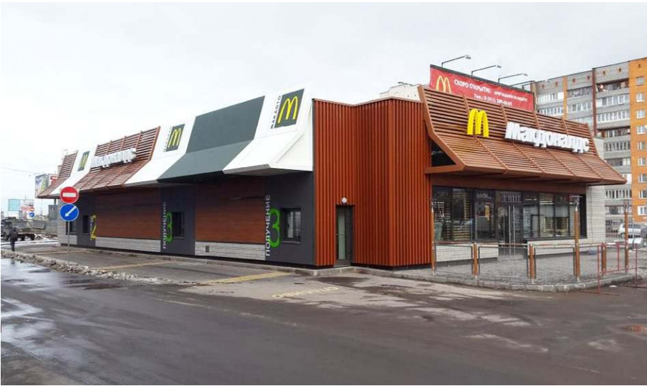
Объект | Ресторан, г. Вологда Изготовитель конструкций | ООО «Цитиус» Система | ALUMARK F50 S70
