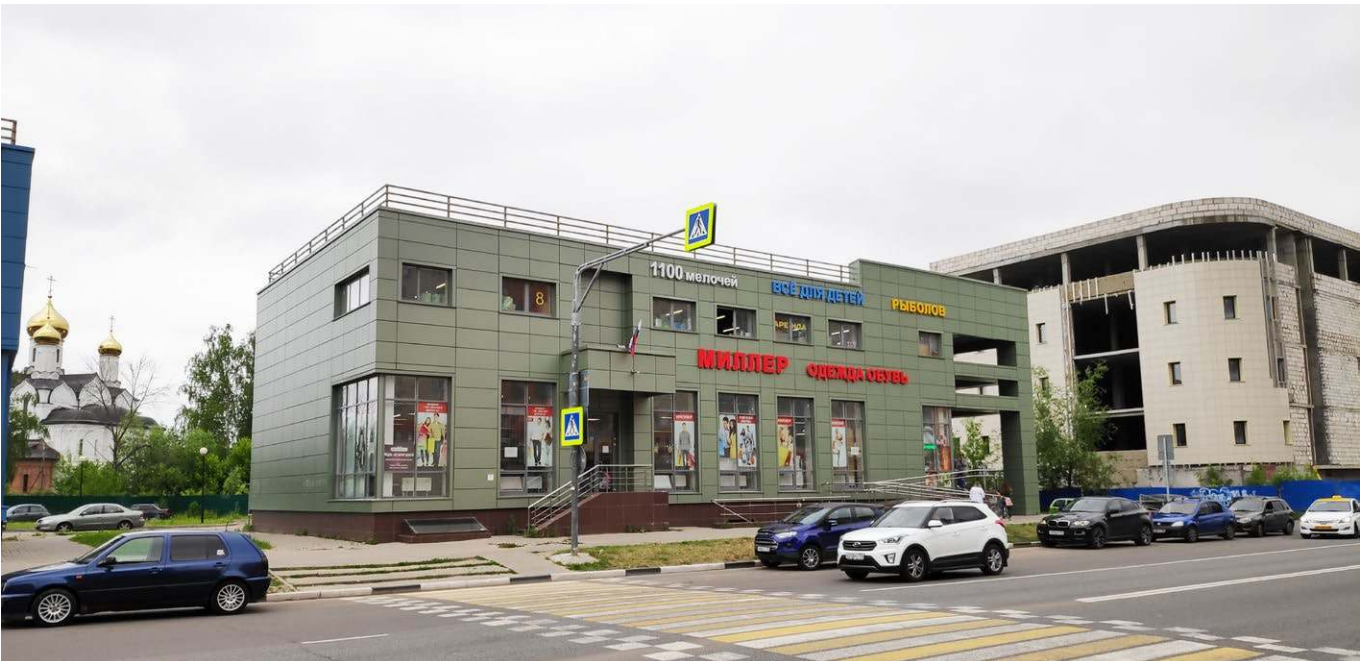
Объект ТЦ "Зима Лето", г. Дубна Изготовитель конструкций ООО Бетиз Система ALUMARK F50, S70
