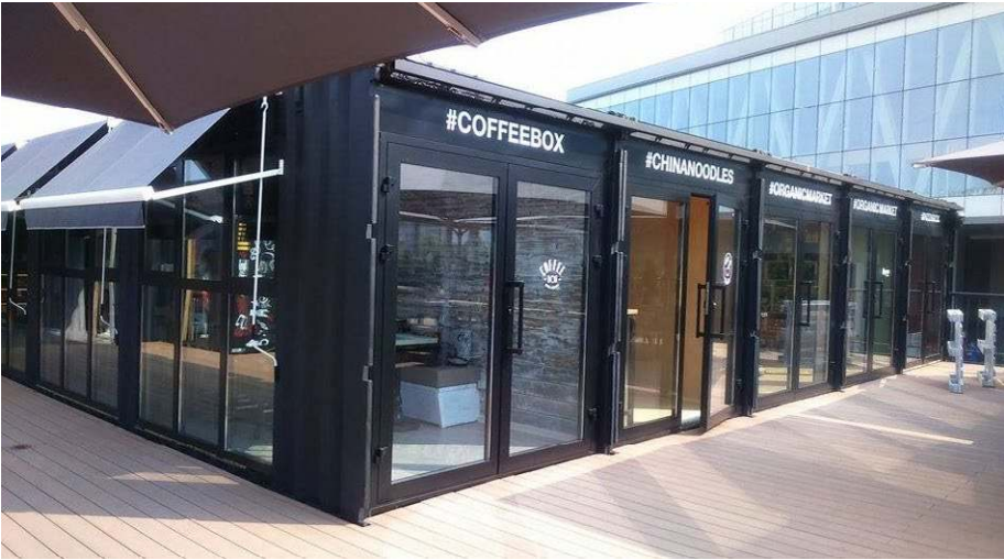
Объект | Москва Сити Изготовитель конструкций | ООО Империял Строй Система | ALUMARK S70
