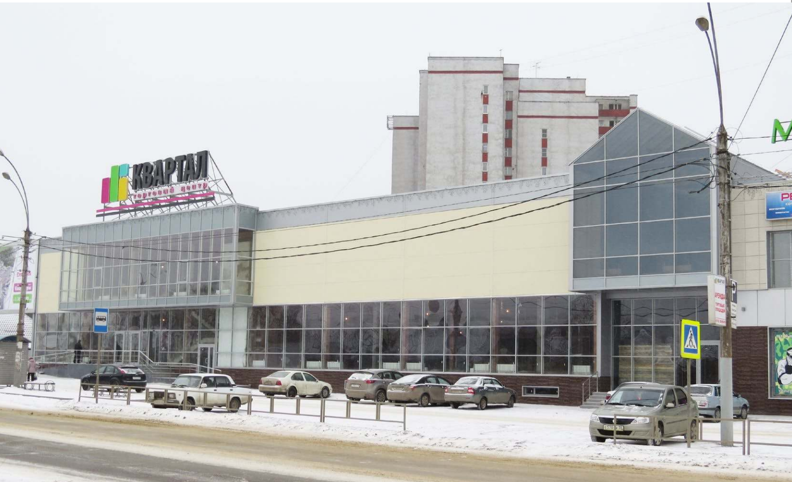
Объект ТЦ Квартал, Липецк Изготовитель конструкций ООО ЛЗСК Система ALUMARK F50, S70
